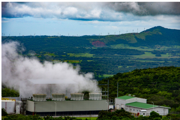
近年盛んに電源開発が進む地熱発電
